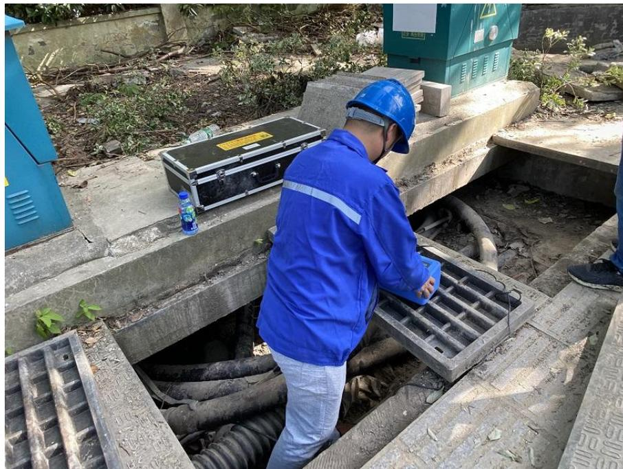
图 A 电缆带电识别现场
