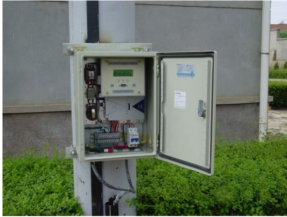
现场安装中央监控器
